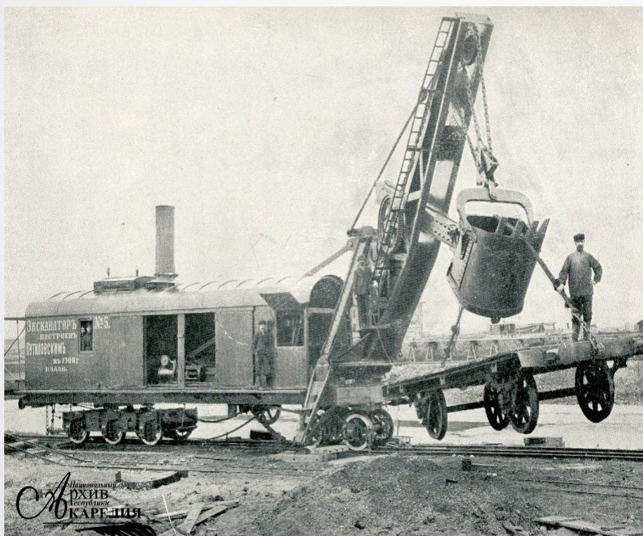
75-тонный одночерпаковый экскаватор «Путиловец». 1916 г.
